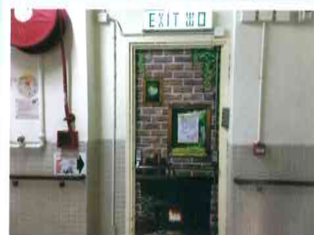
逃生出口門只供緊急情況下使用
